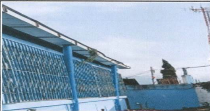
Foto 11: Instalación de canal de agua fluvial.
