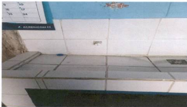
Foto 9: Instalación de chorros.
