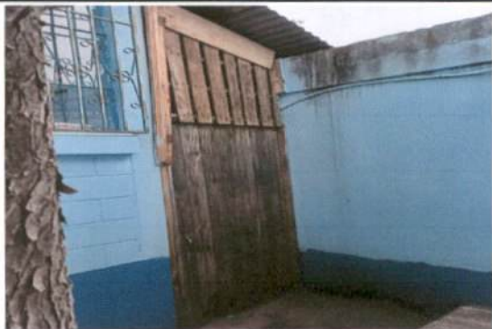
Foto 3: Sustitucion de puertas.
