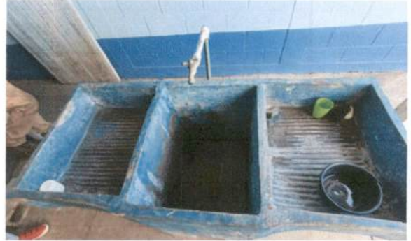
Foto 8: Instalación de pila.
