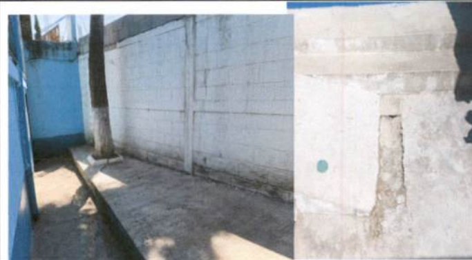
Foto 4: Reparacion de grietas de concreto en patio.
