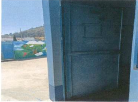
Foto 7: Sustrucción de chapa y mantenimiento de puertas.
